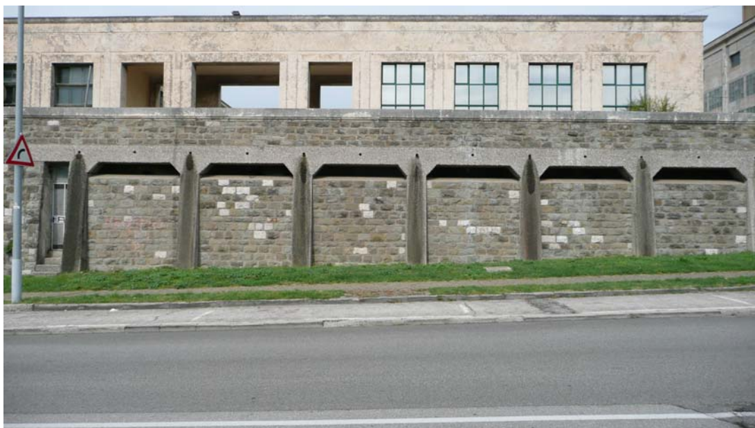
Foto 1- Visuale completa del fabbricato
